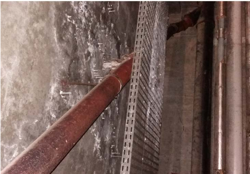
En plafond stalagmites de calcite suite aux infiltrations
