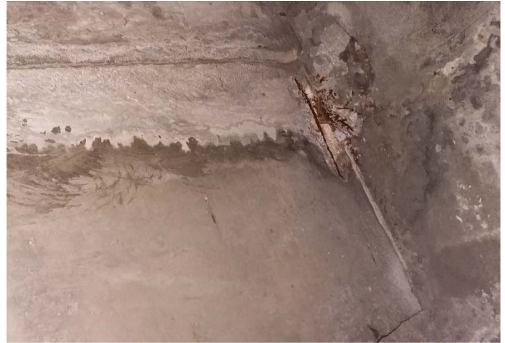
Bétons dégradés aciers corrodés par les infiltrations d'eau
