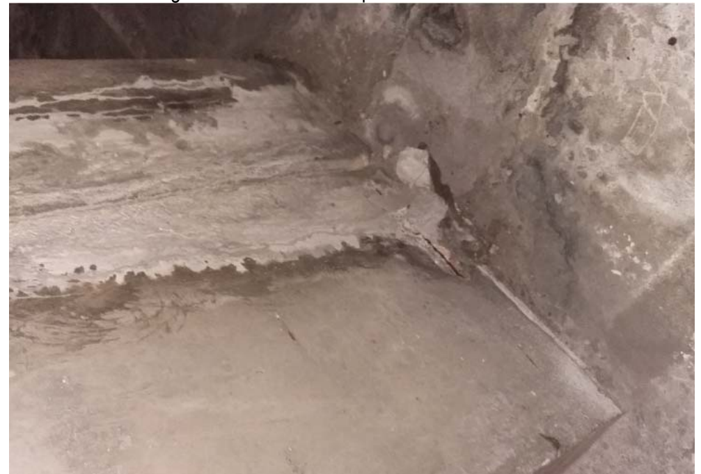
Bétons dégradés aciers corrodés par les infiltrations d'eau au droit d'un joint de dilatation
