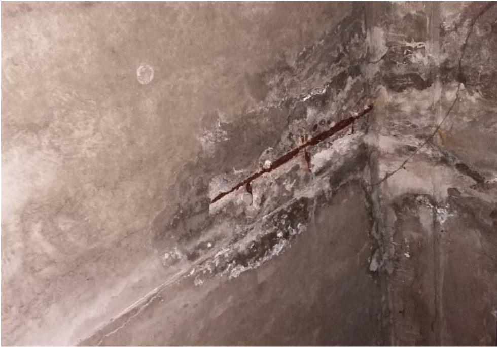
Bétons dégradés aciers corrodés par les infiltrations d'eau
