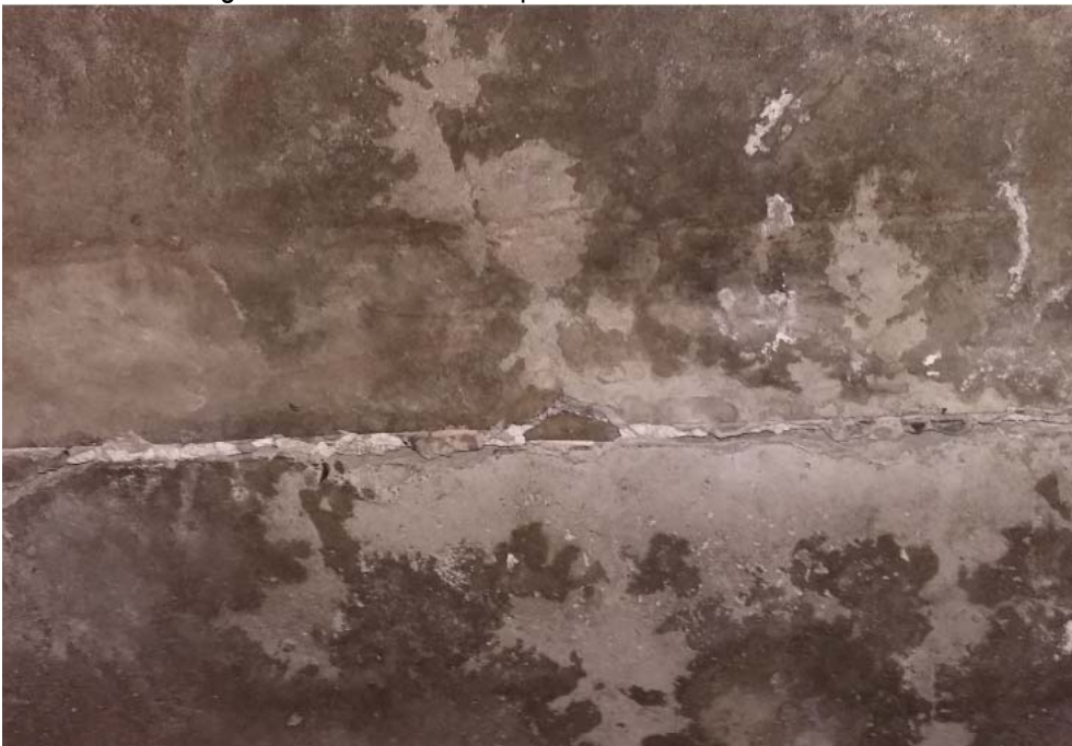
Bétons dégradés aciers corrodés par les infiltrations d'eau au droit d'un joint de dilatation
