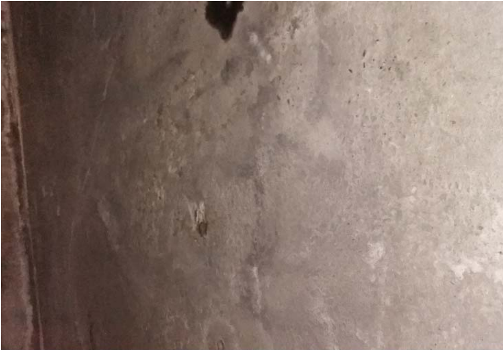
Sur le sol traces d'infiltrations visibles
