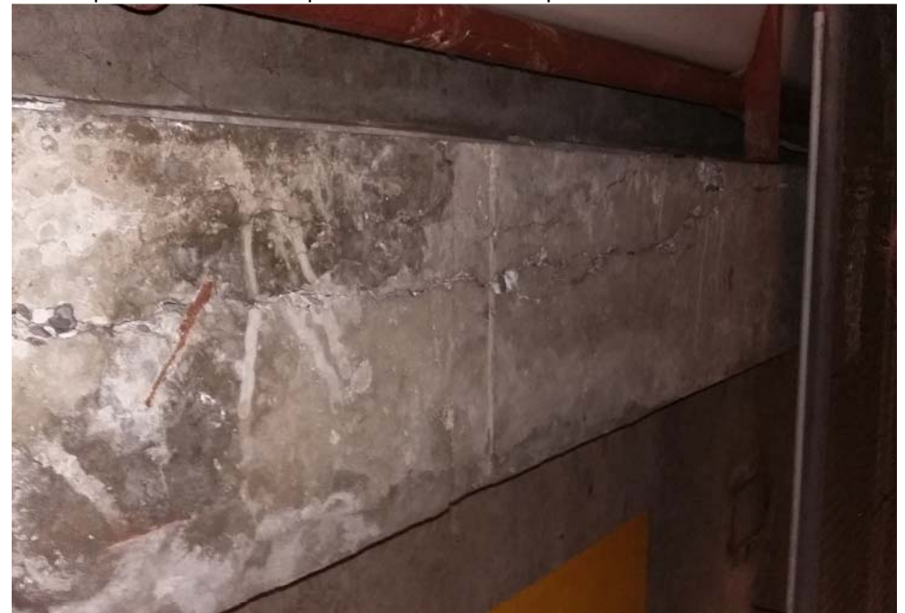
Exemple des traces d'eau restant après les infiltrations
